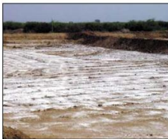
شکل ۱۰- نحوه پخش آهک در کف استخر
