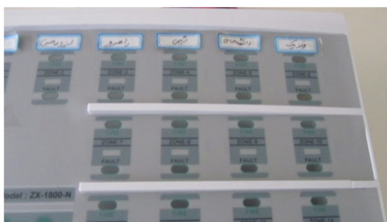
تصویر ۶- نصب تابلو اعلام حریق در آزمایشگاه‌ها (پس از استقرار ایمنی در آزمایشگاه‌ها)
