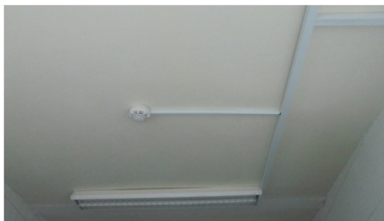
تصویر ۸- نصب دتکتور های اعلام حریق در آزمایشگاه ها
