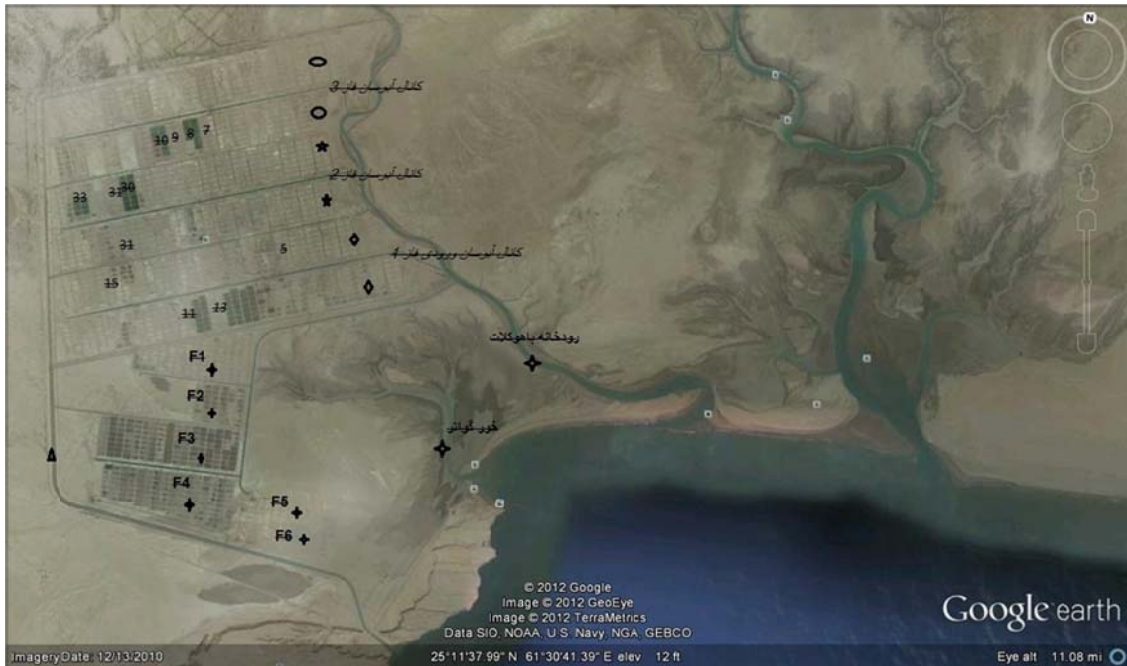
شکل ۵. مجتمع پرورش میگو غرب باهو کلات (Google earth, 2012)
