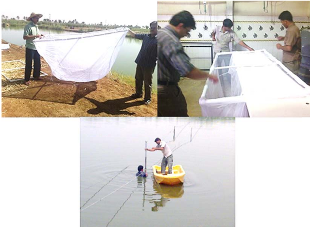
شکل ۵-۲- عملیات ساخت و نصب قفس ها در استخرهای پرورشی
