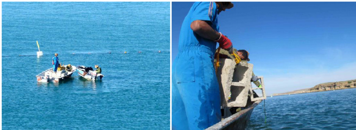
شکل ۹ - حمل بلوکها با قایق جهت ایجاد بستر مصنوعی با استفاده از بلوکهای سیمانی
