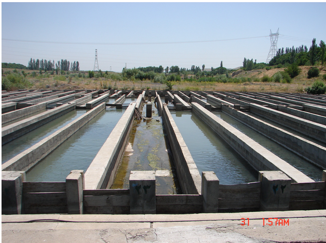
مراغه سد علویان آبیاران ( استان آذربایجان شرقی )
