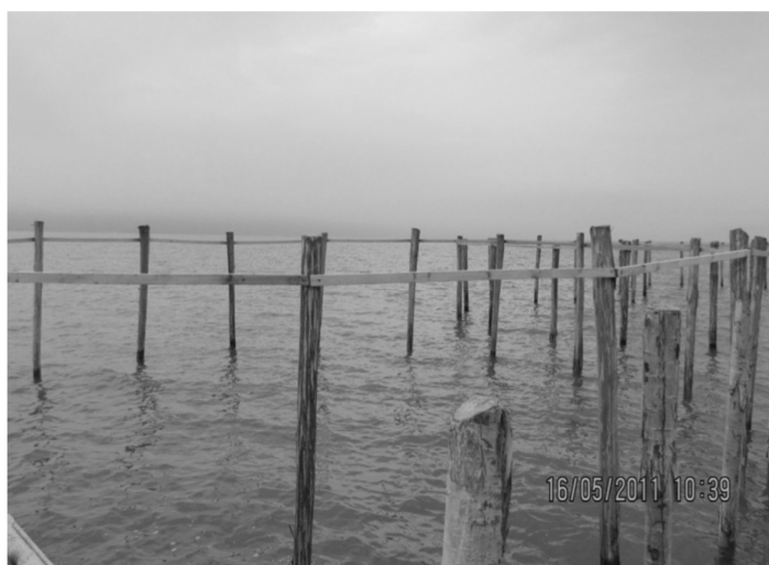
تصویر ( ۱۱ ) نصب تیرکهای چوبی
