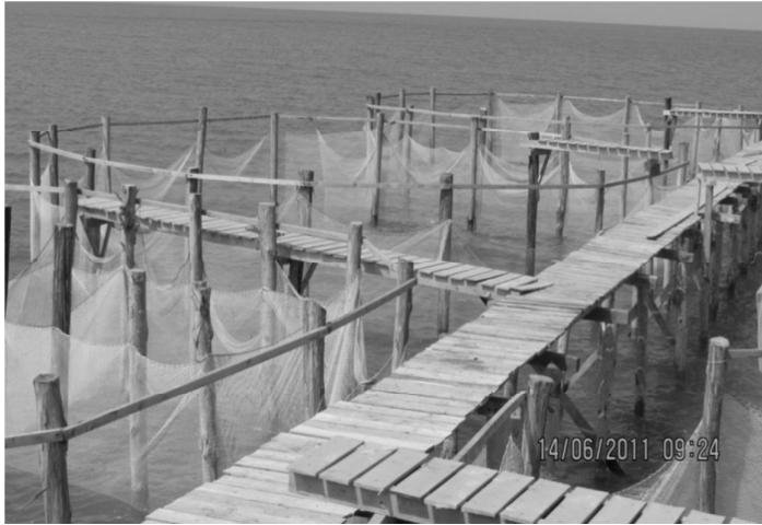
تصویر ( ۱۲ ) ساخت پل های ارتباطی حصارهای توری
