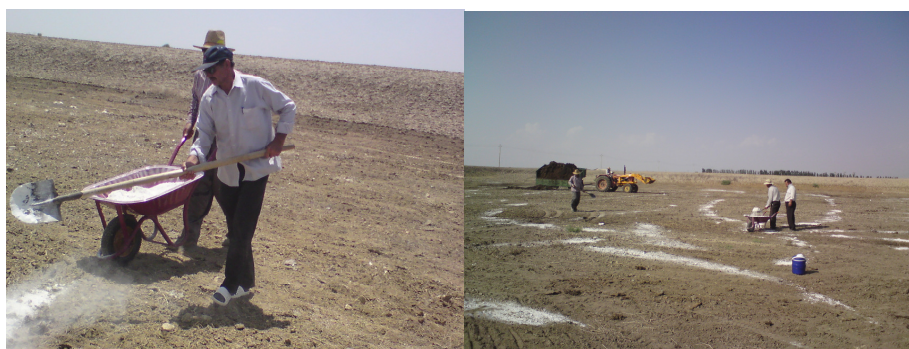
شکل ۲۰: آهک پاشی در استخرهای خشک
