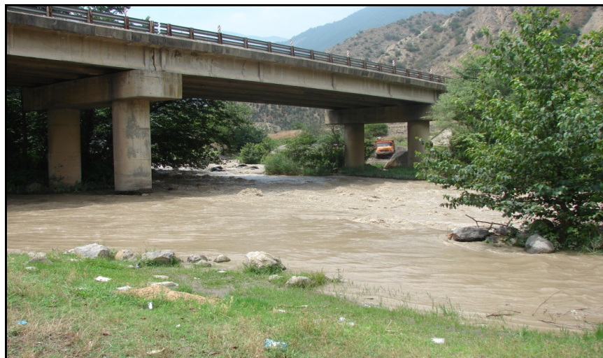
تصویر ۴-۲ محل ایستگاه هیدرومتری زیر پل جلاو بر روی رودخانه هراز به منظور انجام آزمایشات میکروبی
