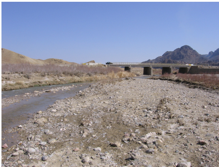
شکل ۹- ایستگاه ۳ نمونه برداری
