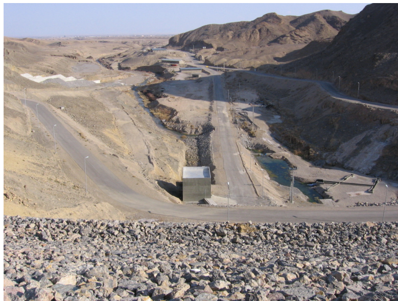
شکل ۱۰- ایستگاه ۴ نمونه برداری
