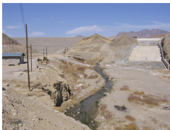
شکل ۱۱- ایستگاه ۵ نمونه برداری
