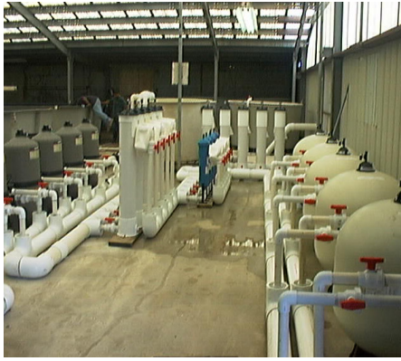
سیستم فیلتراسیون و تمییز کننده آب دریا در سالن تفریح (مکزیک)
