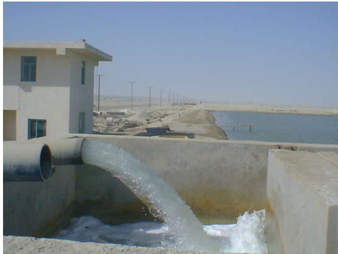
نمایی از لوله پمپ آب و استخر بتنی اولیه (عکس از اژدها کش)
