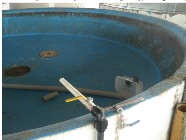
تصویر ۱۱: تعمیر و اصلاح سیستم ورودی و خروجی حوضچه ها
