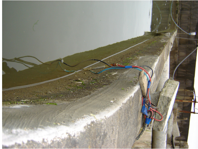
تصویر ۵ : قرار گیری سنسور کنترل ارتفاع آب در داخل حوضچه رسوبگیر
