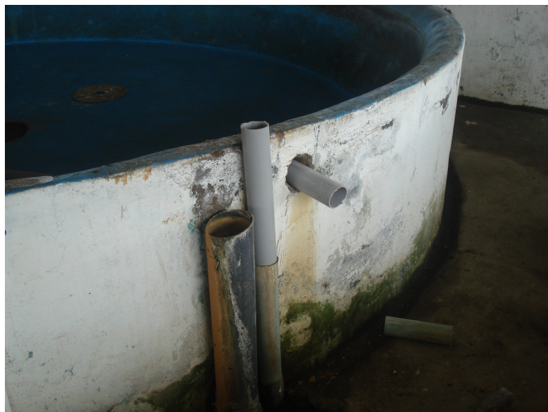
تصویر ۱۵ : نحوه کارگذاری لوله خروجی مرتبط به ظروف و اصلاح لوله خروجی مرکزی
