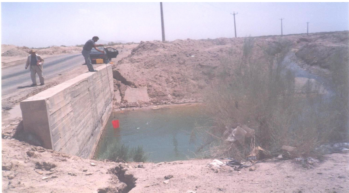
شکل ۲-۳ - نمایی از زهکش حایل - ورزنه
