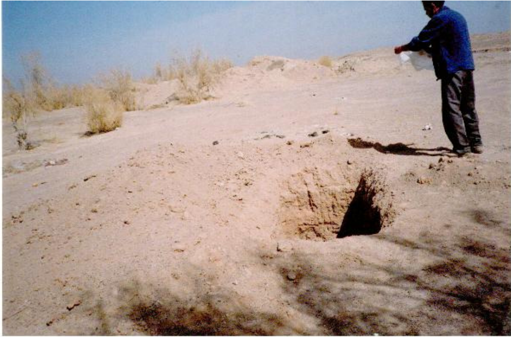
نمایی از گمانه حفاری شده برای انجام آزمایش خاک در زهکش حایل
