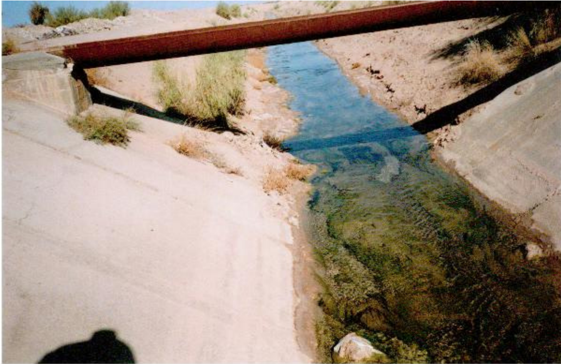
شکل ۲-۲ - زهکش حایل - ۴ کیلومتر بالاتر از ایستگاه پمپاژ
