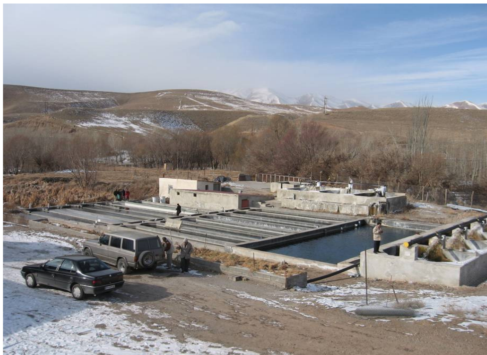
شکل ۳-۲: تصویری از کارگاه آقای لیموچی در اهر
