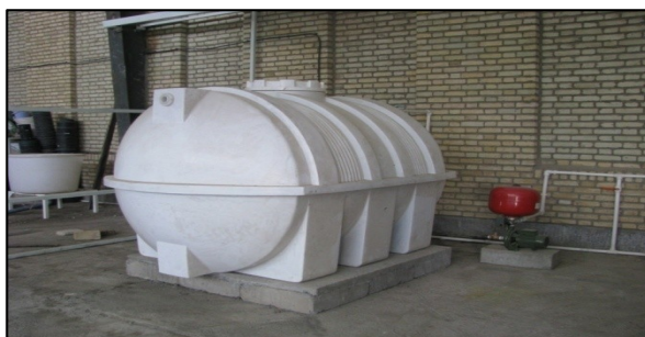
شکل ۹: سکوی سیمانی جهت قرار گرفتن تانک ۳۰۰۰ لیتری
