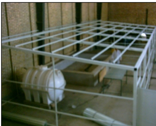
شکل ۴: داربست فلزی اطراف استخر
