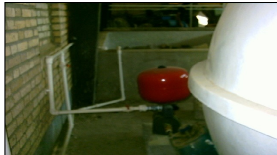
شکل ۳: قسمتی از لوله کشی آب به سمت تانک (چپ) و لوله کشی آب به سمت اتاقک ایزوله (راست)
