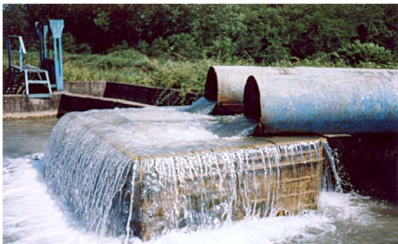
تصویر ۱۳: استفاده از آب رودخانه خرارود جهت آبیگری استخرها
