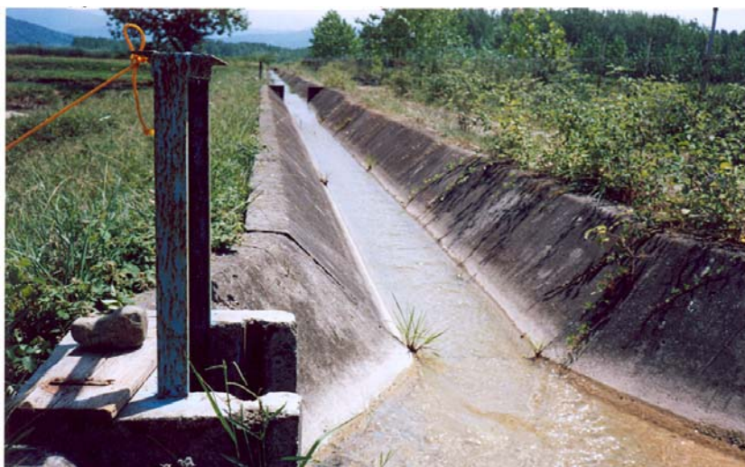
تصویر ۱۴: کانالهای بتونی انتقال آب
