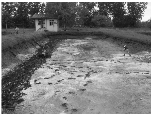
شکل ۲۷: شخم زنی و آهک پاشی استخرهای خاکی
