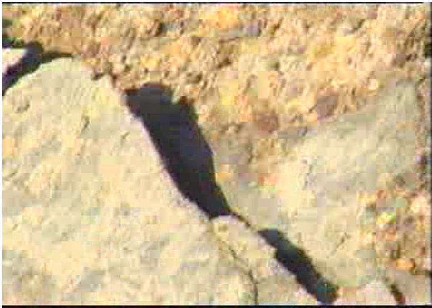
شکل ۲۶: فرسایش شدید و شکستگی در دیواره کانالهای بتونی آب رسانی تعدادی از مزارع در منطقه
