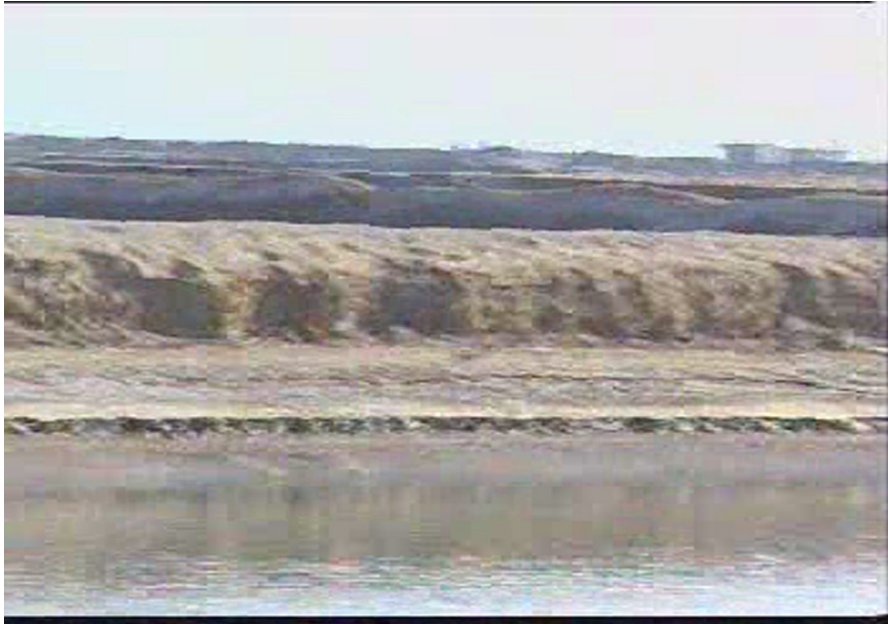
شکل ۲۵: تخریب دیواره استخرها در تعدادی از مزارع مستقر در منطقه سایه خوش
