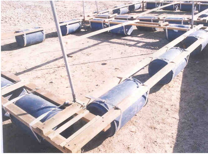
(۱) قفس شناور فرم اصلی از چوب و شناور ها از بشکه پلاستیکی ۱۸۰ لیتری
