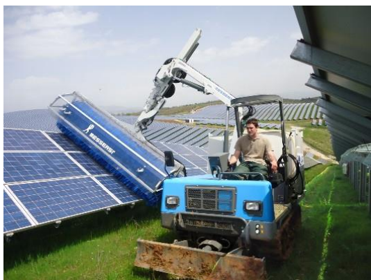
Figura 35 - Operação de limpeza de módulos fotovoltaicos (Messersi 2018)
