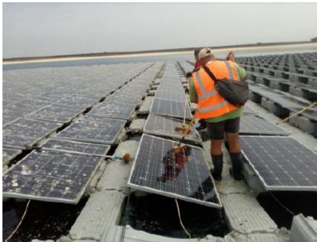
Figura 59 - Operação de limpeza dos módulos da central B
