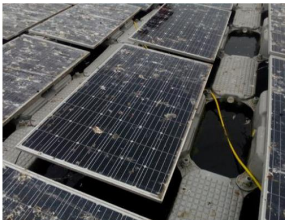
Figura 58 - Módulo instalado na central B com excrementos na sua superfície
