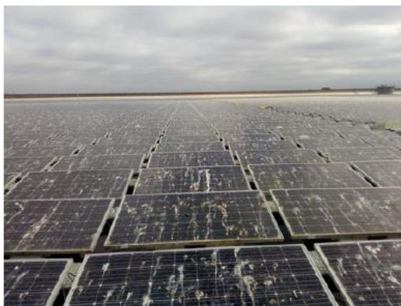
Figura 58 - Módulo instalado na central B com excrementos na sua superfície
