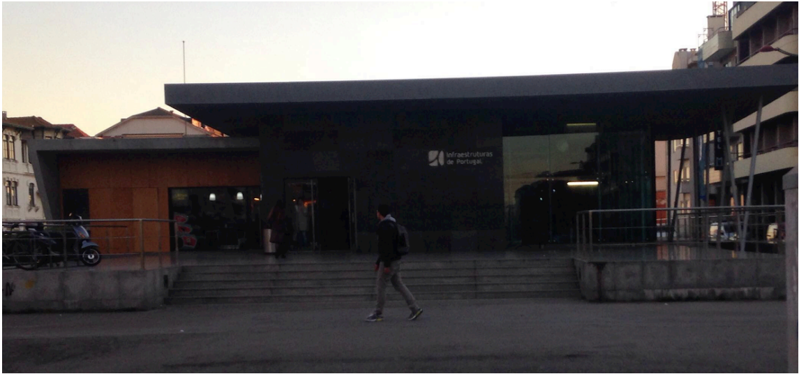
Fig. 4.14 – Entrada principal da estação ferroviária de Espinho.[foto do Autor]
