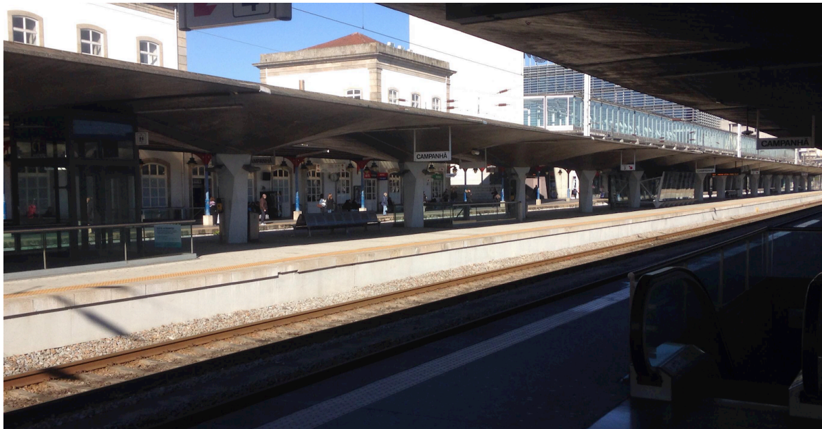
Fig. 4.3 – Interior (a céu aberto) da estação ferroviária de Campanhã.[Foto do Autor]
