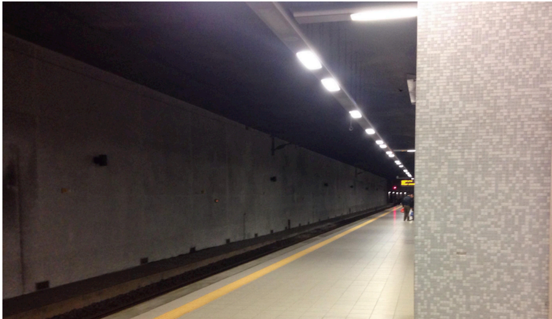
Fig. 4.15 – Interior, no subsolo, da estação ferroviária de Espinho.[foto do Autor]
