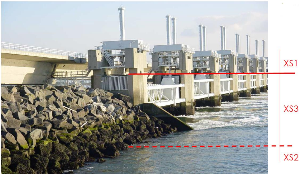
Figura 3.1 - Exemplo de diferentes classes de exposição numa estrutura marítima (Paulo Cachim, Universidade de Aveiro)
