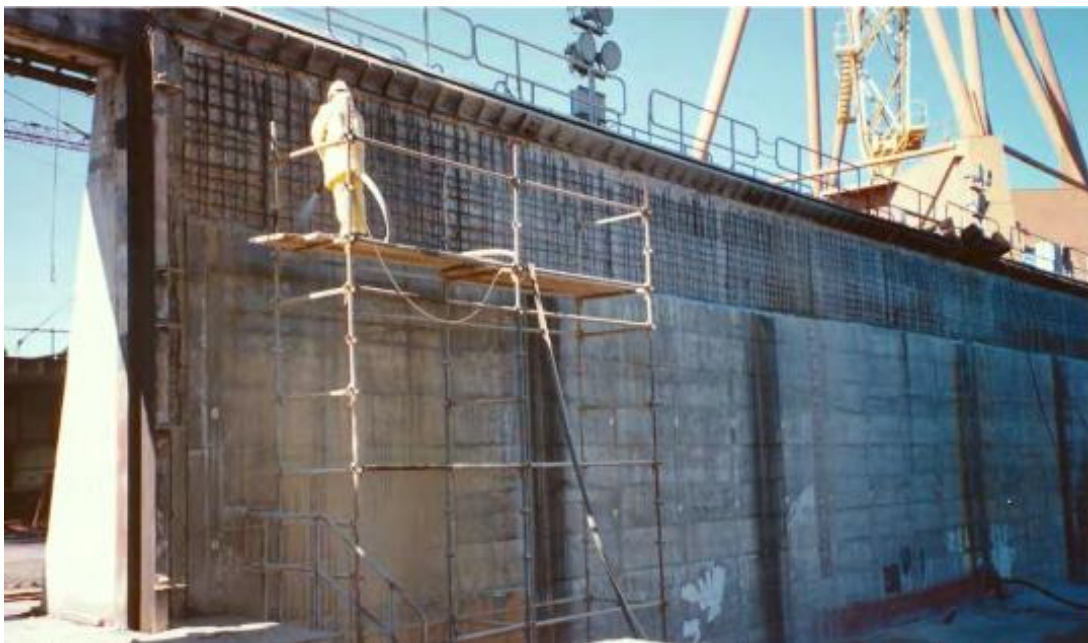
Figura 4.4 - Aplicação de betão projetado nas docas da Lisnave (Apeb)
