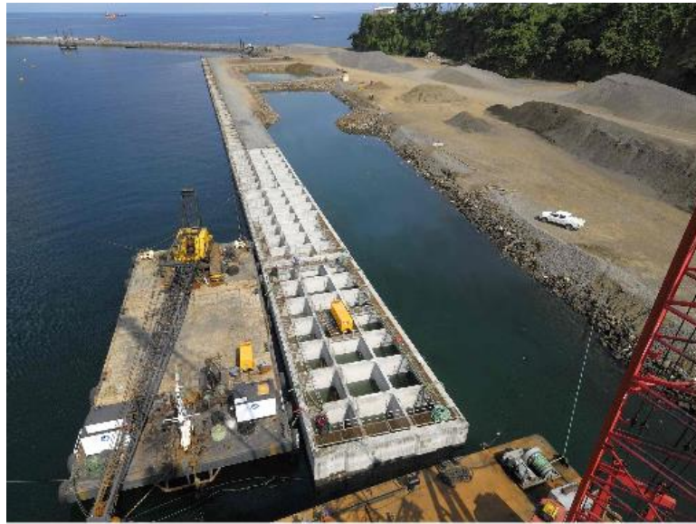
Figura 2.21 - Exemplo de caixotões pré-fabricados para a construção de cais no porto de Malabo, Guiné Equatorial (Etermar, 2018)
