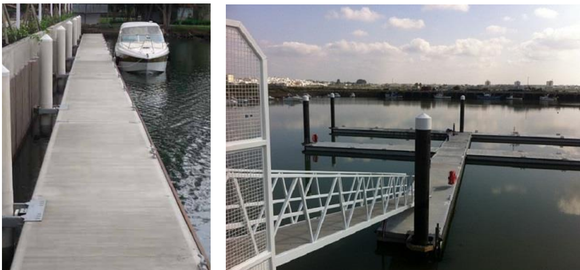
Figura 3.30 - Esquema de pontões flutuantes em betão (Lindley)
