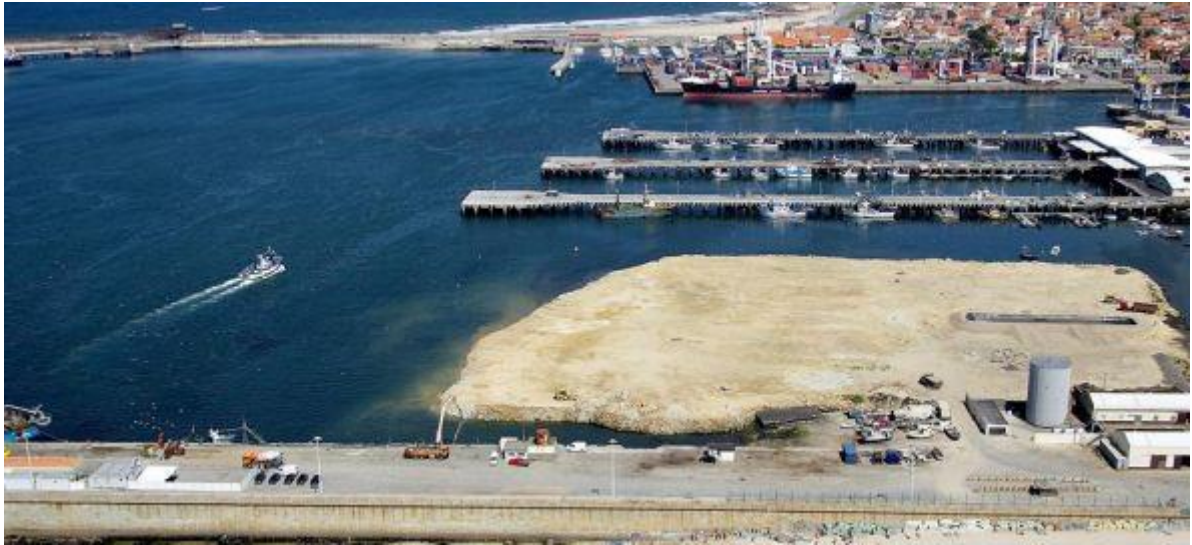
Figura 3.13 - Terrapleno do terminal multiusos de Leixões (Irmãos Cavaco)
