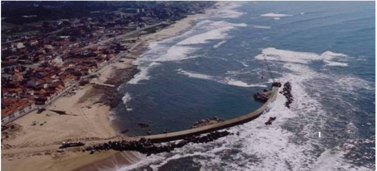
Figura 3.22 - Quebramar destacado da Aguda construído em betão ciclópico (Irmãos Cavaco)
