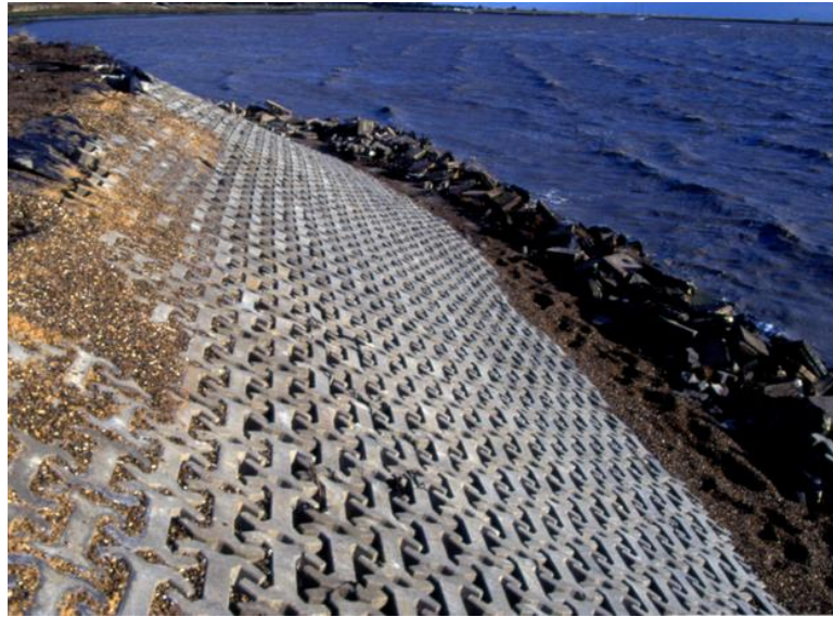
Figura 3.25 - Exemplo de revestimento costeiro em blocos de betão (External Works)
