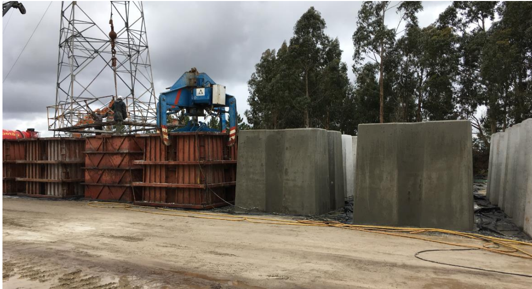
Figura 5.8 - Exemplo de blocos antifer recém betonados (Abril de 2018, fonte própria)
