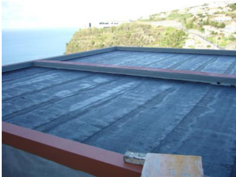
Figura 4.3 - Aplicação de tela asfáltica em cobertura de moradia (onossopalacio.blogspot.com)
