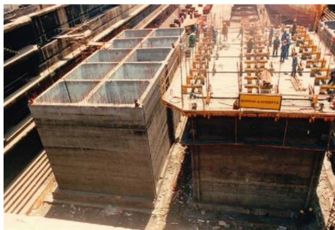
Figura 3.12 - Construção de caixão para doca no porto de Cape Town (Mark Alexander, 2018)
