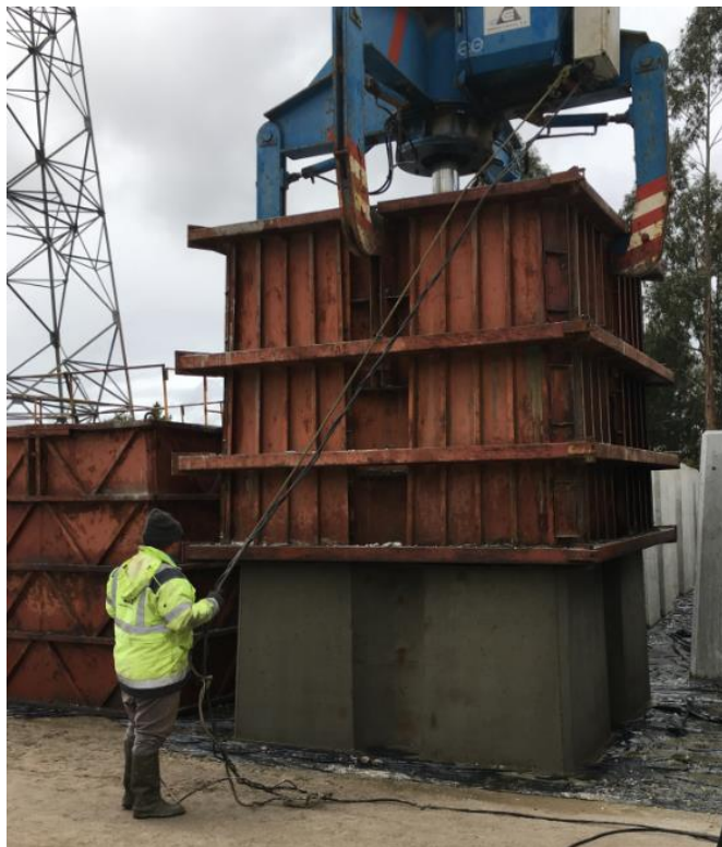
Figura 5.9 - Descofragem dos blocos (Abril de 2018, fonte própria)
