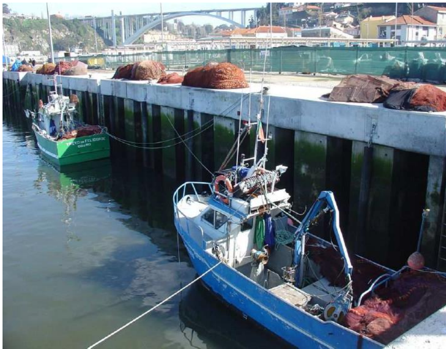
Figura 3.14 - Cais do porto de pesca da Afurada construído em blocos NOREF (Veloso Gomes)
