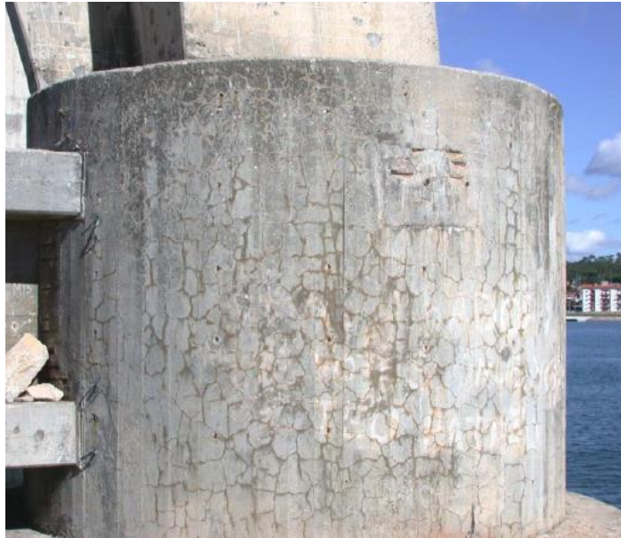
Figura 2.11 - Efeito da retração térmica em elemento de grandes dimensões (Costa, 1997)
