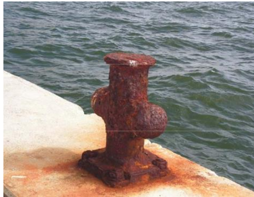
Figura 2.19 - Exemplo de corrosão uniforme (Tiago Santos, 2014)
