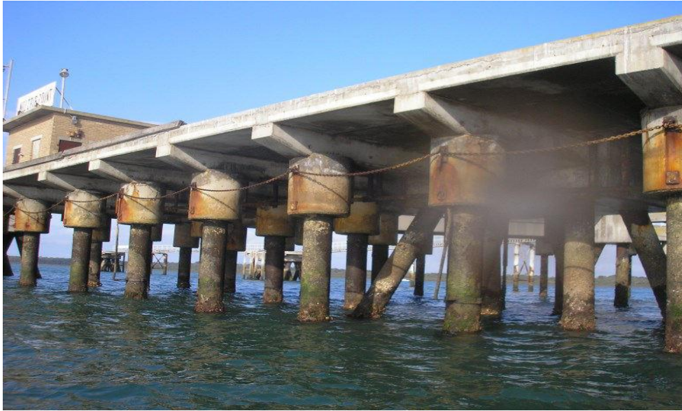
Figura 3.32 – Ponte cais ( pier ) construída em betão (Infracorr)
