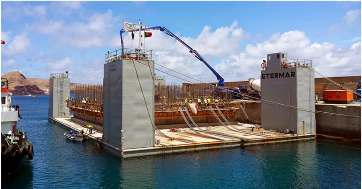
Figura 3.16 - Estrutura flutuante para fabrico de caixotões (Etermar)
