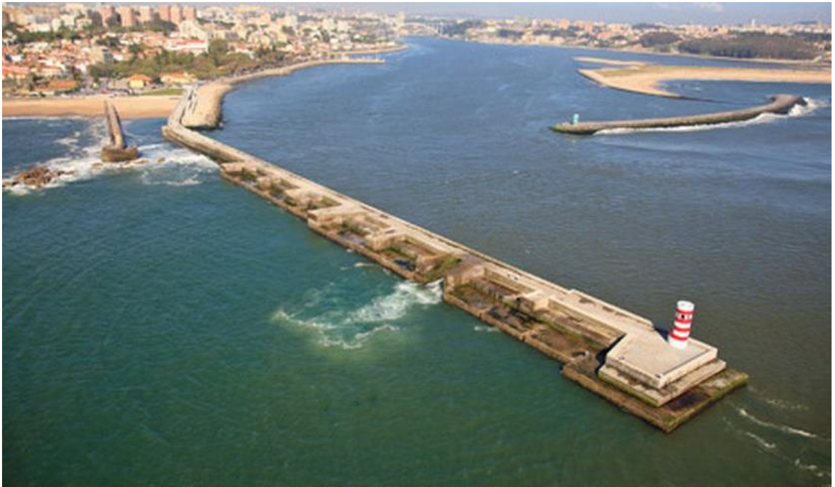
Figura 3.28 - Molhes do Douro construídos por caixotões celulares em betão armado (Jornal de Notícias)
