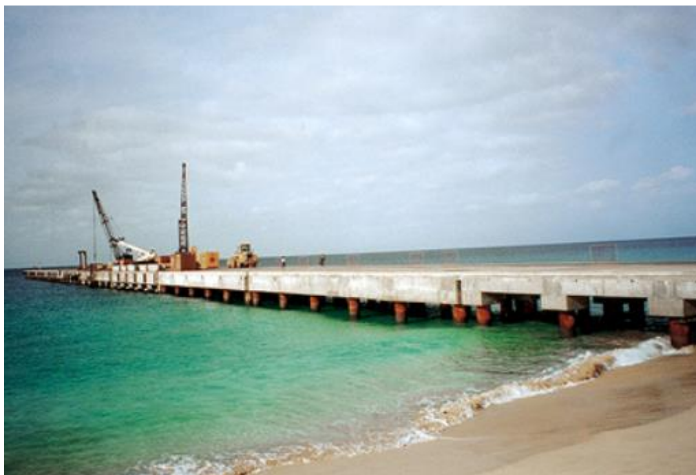
Figura 3.31 - Ponte cais em betão ( piér ) situada em Cabo Verde (Somague)
