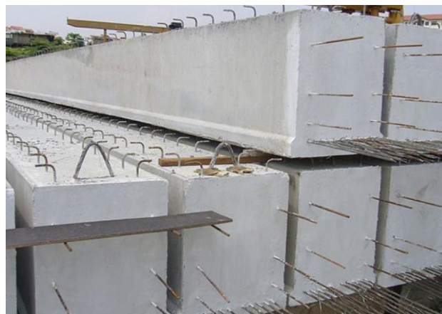
Figura 2.20 - Exemplo de betão pré-esforçado (www.engenhariacivil.com)
