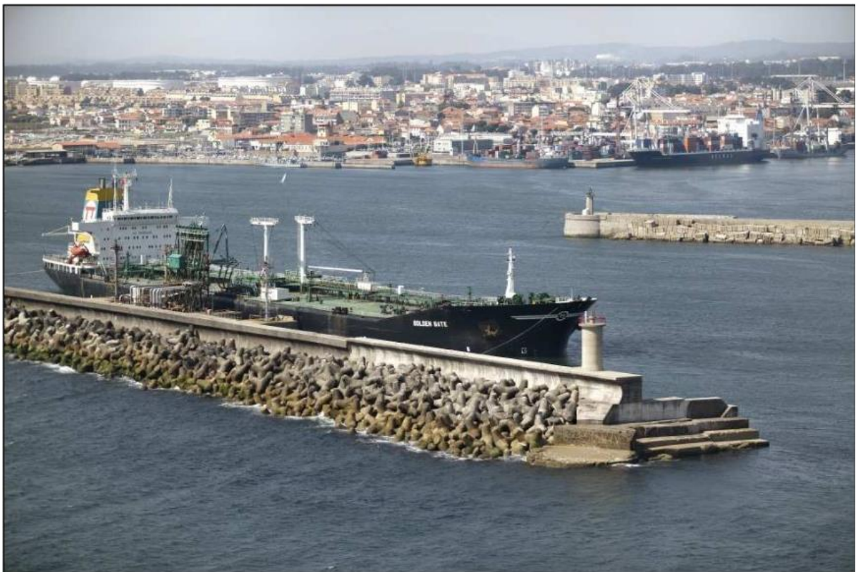
Figura 3.20 - Quebramar de taludes constituído por blocos tetrápodes em betão, TPL de Leixões (APDL)
