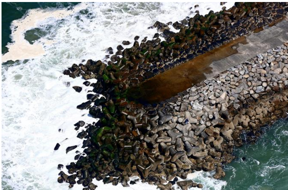
Figura 5.6 - Imagem representativa da destruição dos blocos e do seu completo desarranjo datada de 2015 (Francisco Piqueiro)
