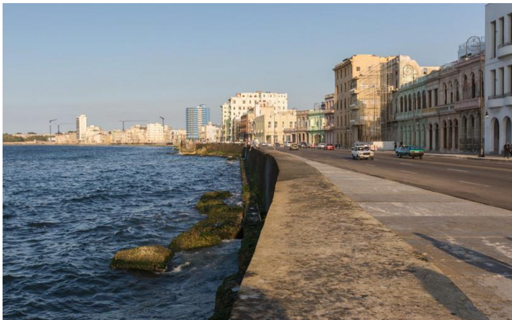
Figura 3.24 – Exemplo de um paredão, seawall (Seawall Doctors)
