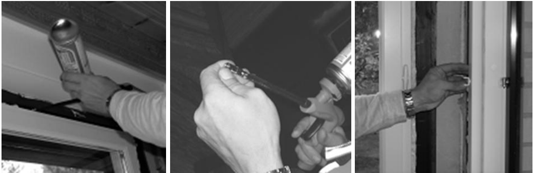
Kuvat 9-11: Työvaiheita ikkunoiden tiivistämisessä
