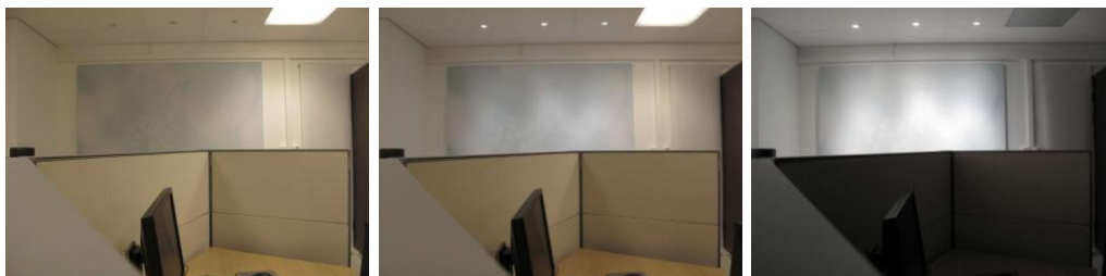
Kuva 2.6.5. Esimerkki seinävalaistuksen toteutuksesta. Kuvat otettu tilanteessa SIS2. Vasemmalla seinävalot on sammutettu ja keskellä ne ovat päällä. Oikealla seinävalot on päällä ja yleisvalaistus sammutettu.
