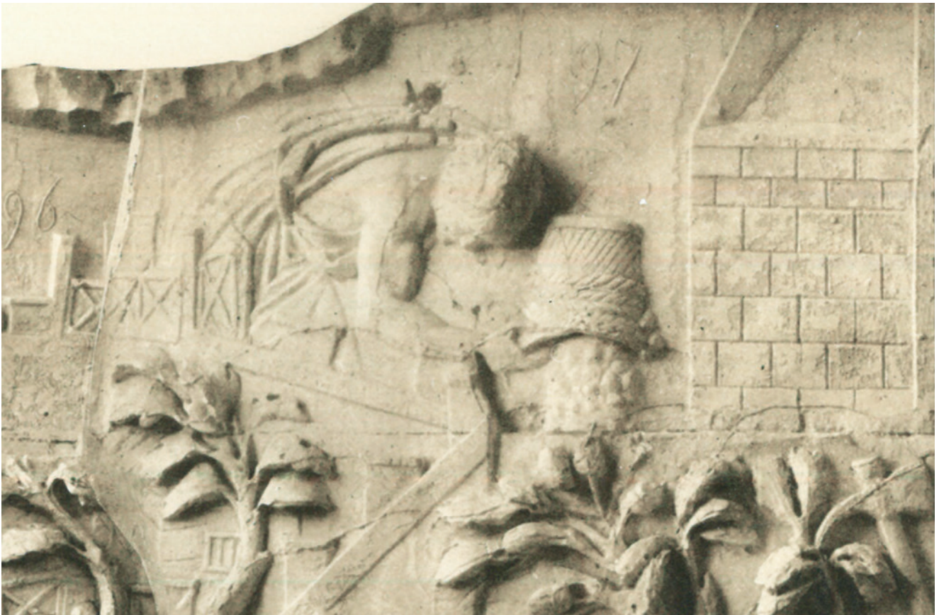
Abb. 3: Trajanssäule in Rom (I): Römische Legionäre bauen eine Stadtmauer. Verblendet mit Naturstein, bestand der Kern der Mauer aus opus caementitium . Der Reliefausschnitt zeigt, wie das Gemisch aus Mörtel und kleinen Bruchsteinen, das sogenannte caementum , aus einem Korb in die Schalung geschüttet wird (Cichorius 1900, Taf. LXVII, XCII.243 [Hintergrundszene]).
