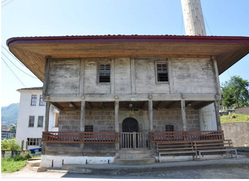
Şekil 6. Mithat Paşa Camii Giriş Cephesi
