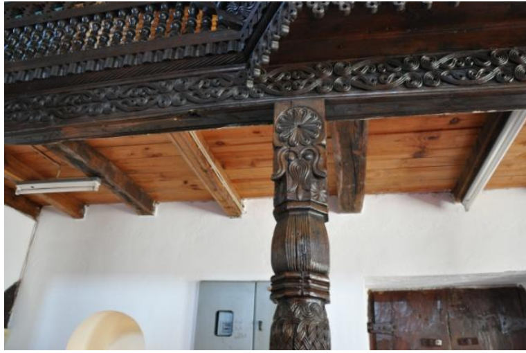
Şekil 10. Harimden Ahşap Dikme Örneği
