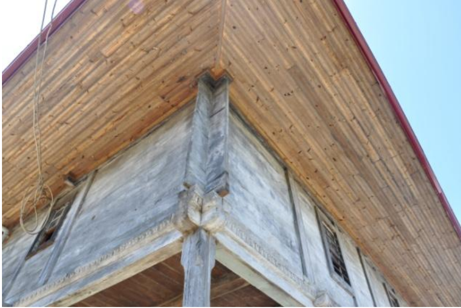
Şekil 8. Kuzeydoğu Köşesi Çantı Detayı
