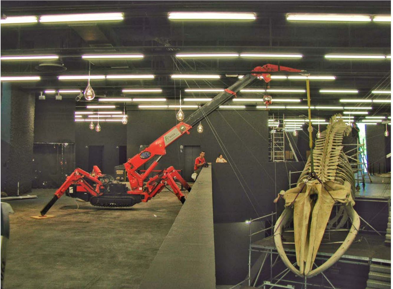
Figura 13. Proceso de montaje de la cabeza, con ayuda de una grúa fija sobre el forjado.
