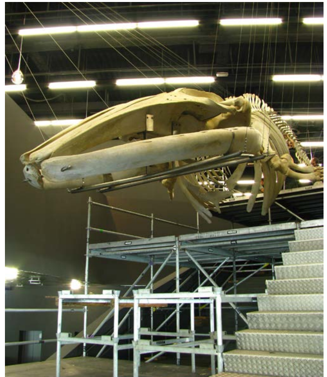
Figura 14. La estructura en carga, antes de ser desmontado el andamio de trabajo.
