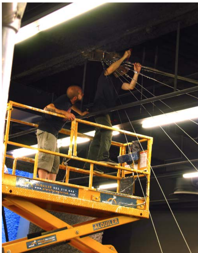
Figura 5. Proceso de ajuste de los cables en obra por los técnicos de GROF, en uno de los cuatro apoyos.
