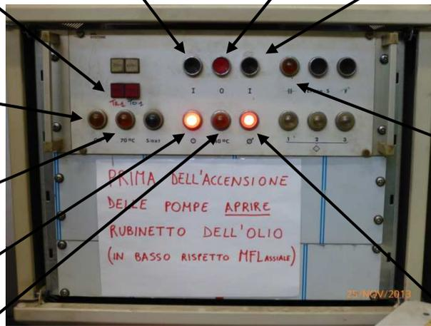
Figura 5.44: Pannello di controllo pompe idrauliche
