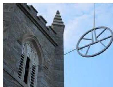
Figs. 230 e 231 Rodas de sino e elevação de roda de sino para campanário
