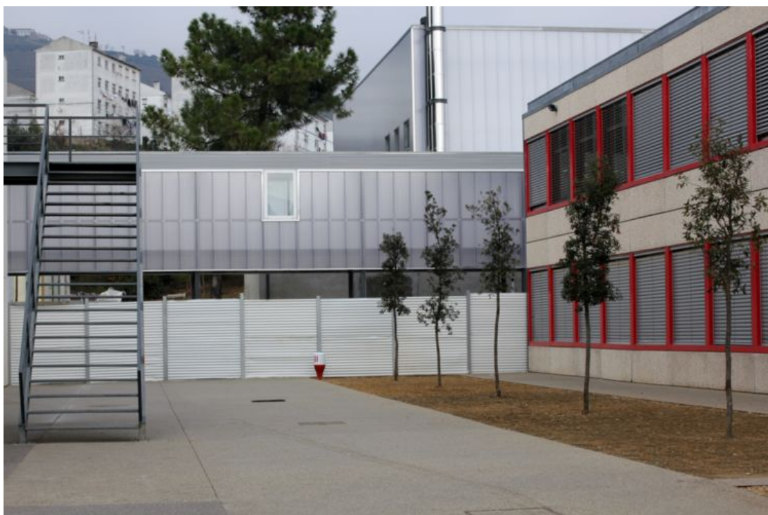
Figura 10 – Aspecto geral do exterior da Escola Secundária Dr. João Araújo Correia (corredor entre pavilhões).
