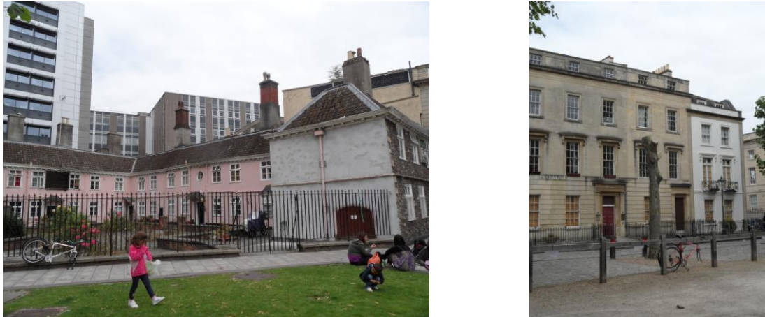
Figura 5 – Edifícios do centro da cidade de Bristol (créditos A. Tavares)
