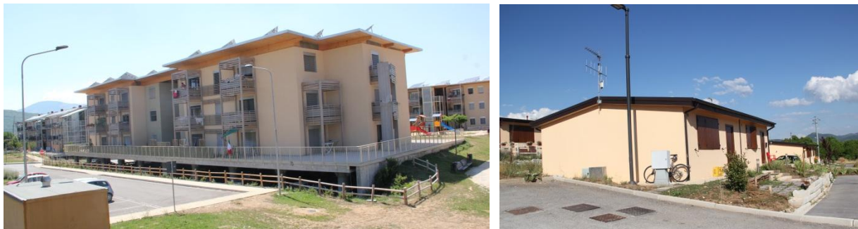
Figura 9: Construção de realojamento pós-sismo
