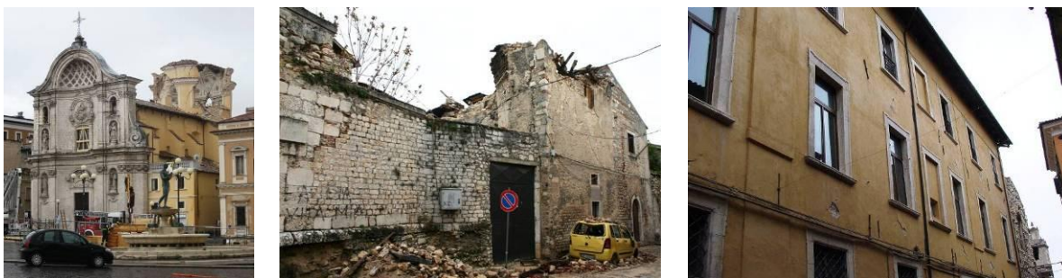
Figura 1: Danos em estruturas de alvenaria tradicional no centro de L'Aquila
