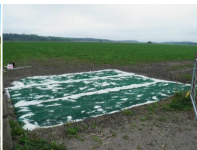
Bild 3. Anlagd armering
