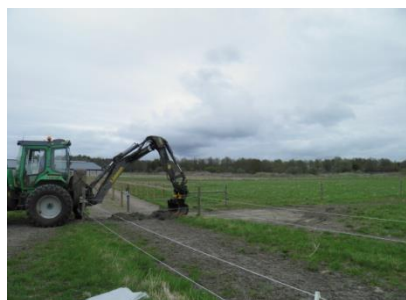
Bild 1. Preparering av yta
