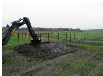
Bild 4. Preparering av yta
