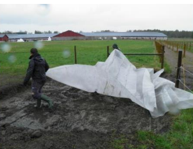
Bild 5. Placering av geotextil
