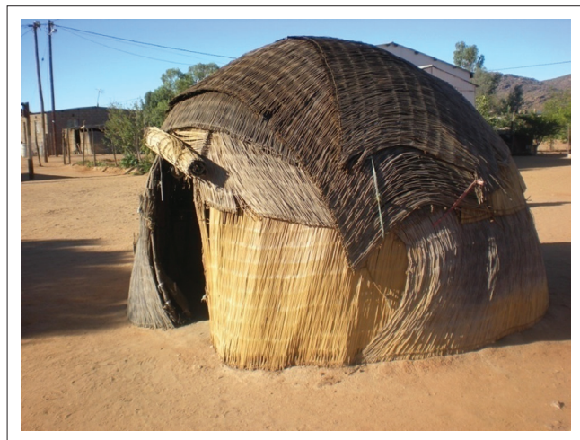
FIGUUR 1: Die konstruksie van 'n matjieshuis.
