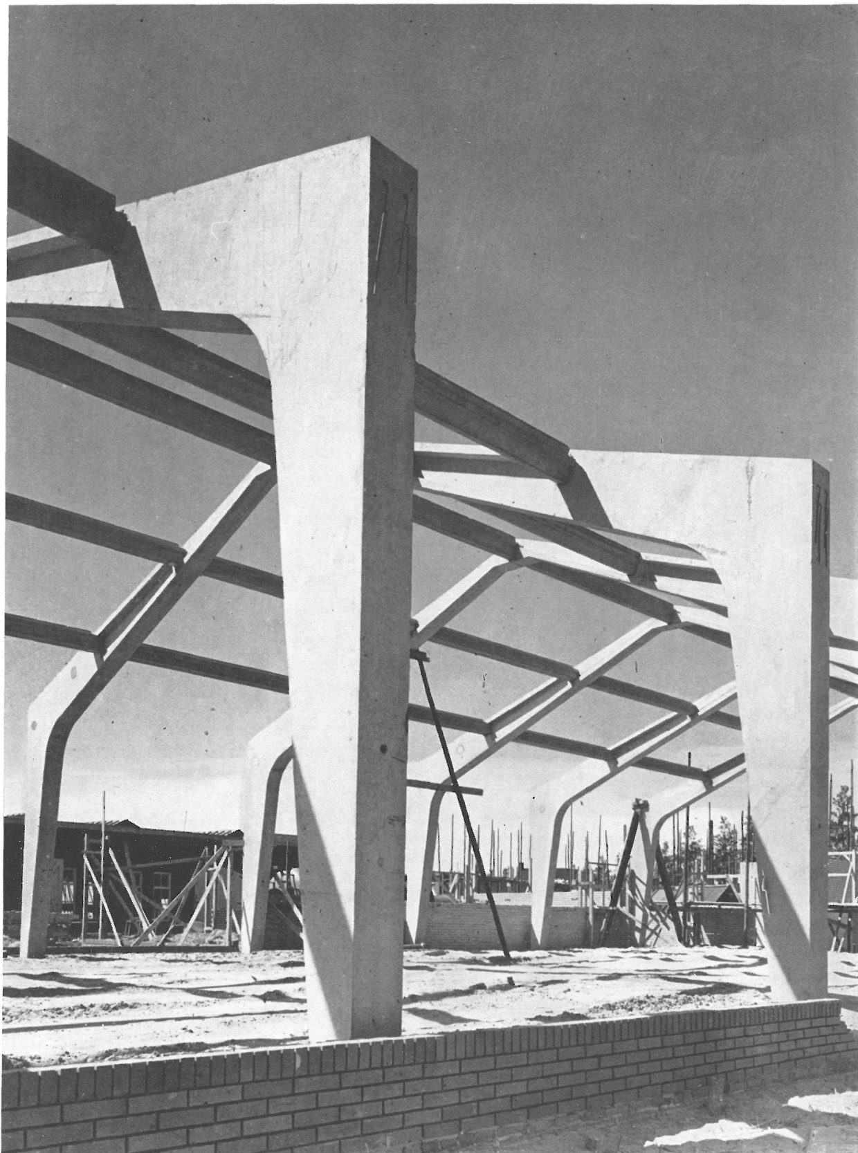
Pórticos de una nave industrial premoldeados en Schokbeton
