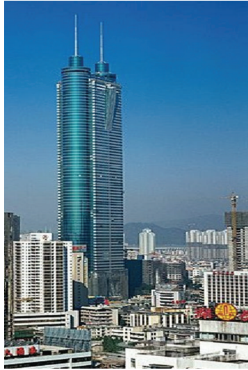
(a) Di Wang Building
