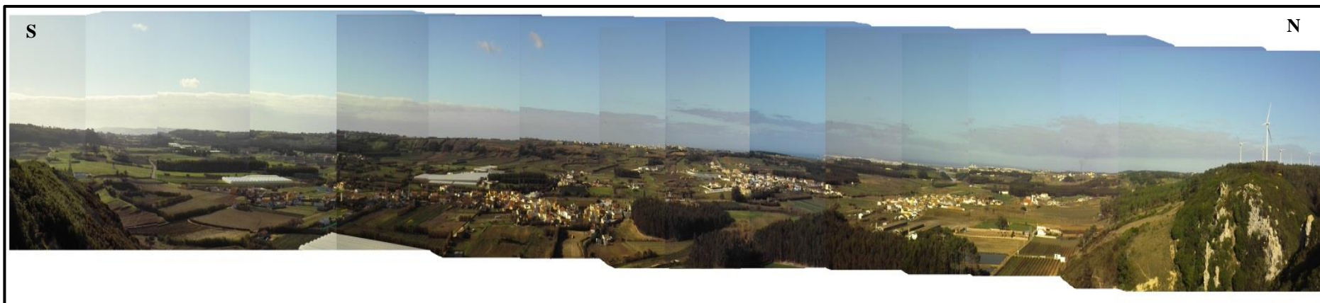
Figura II. 14: Vista panorâmica para oeste a partir do Planalto da Cesareda.
