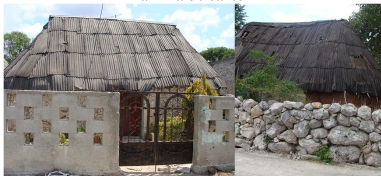
Fotografía 2. Viviendas con cubiertas de lámina de cartón
