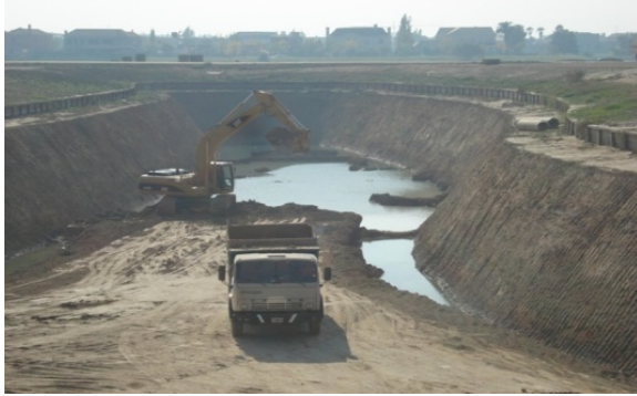
Figura N° 4: Técnicas de excavación, empleadas mediante retroexcavadoras y camiones (izquierda) o a través del dragado (derecha)
