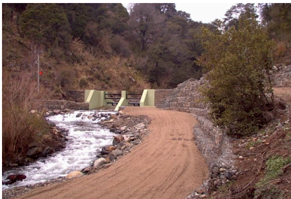
Figura 5.4: Presa selectiva para la retención de grandes piedras y restos leñosos (izq.) y área de retención de sedimentos aguas abajo (der.)
