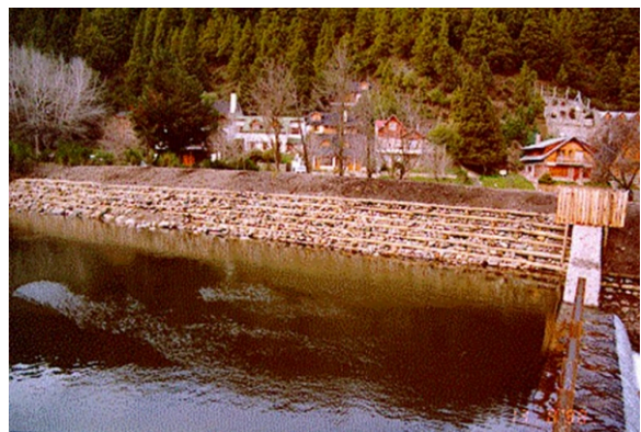
Figura 5.4: Presa selectiva para la retención de grandes piedras y restos leñosos (izq.) y área de retención de sedimentos aguas abajo (der.)
