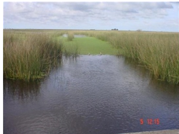
Fotos N° 3 y N° 4: Inundaciones en el partido de Gral. Lavalle, Pcia. de Buenos Aires (R. Argentina). Obras de control (izq.) inefectivas y canales secundarios colmatados por sedimentos y vegetación palustre (der.) (Fotos: PR; RS, UNLP, 2002).
