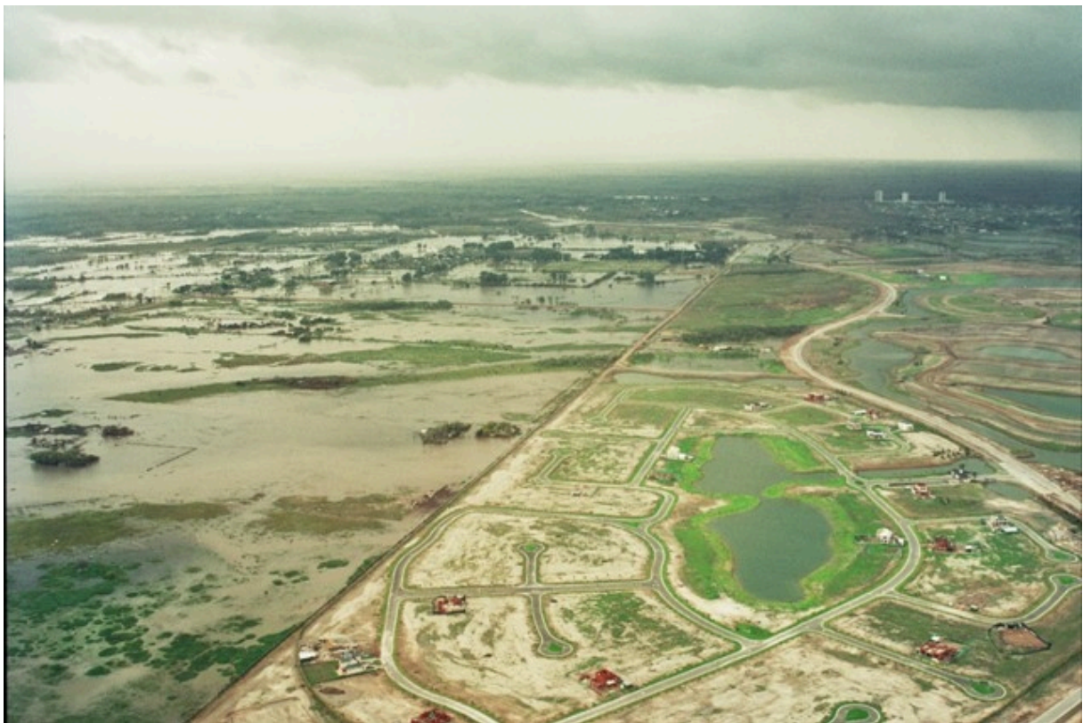
Figura N° 5: Vista del efecto de las obras de protección bajo la influencia de una sudestada. A la izquierda terreno natural y a la derecha se observa los resultados de la elevación artificial de la cota del terreno.
