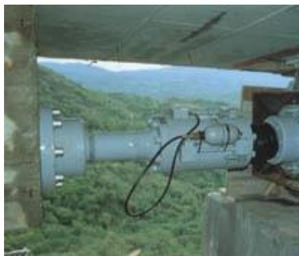
Figura 85: Shock transmitter montato su un viadotto
