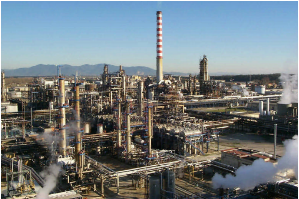
Figura 2.1: vista della Raffineria di Livorno.
