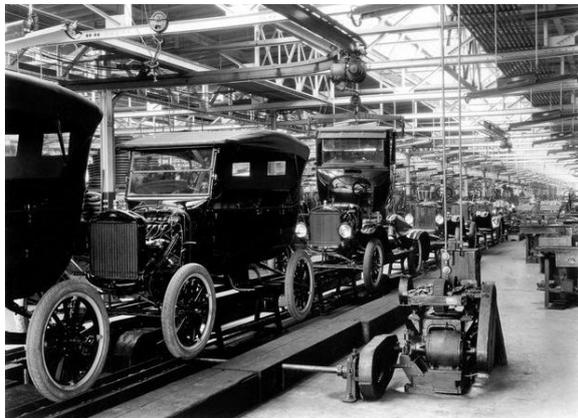
Fig. 4 Catena di montaggio della Ford Model T
