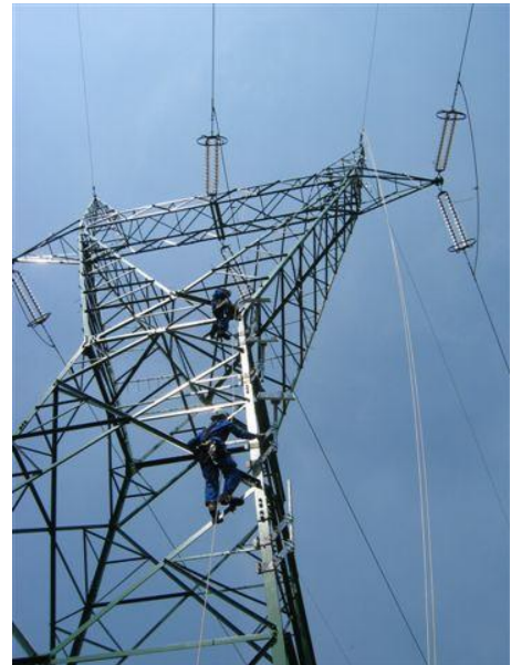
Figura 1.1 - Operatori su un traliccio gestito da Terna
