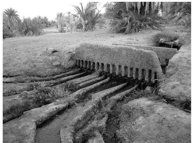
Fig. 3 Secondary kasria of the foggara of El Meghier (Timimoun)
