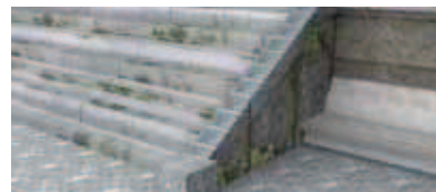
Fig.17: Animación de la escalera que da acceso a la galería de la fachada posterior, se observan los bloques de granito. Fuente: PFG.RLJ
