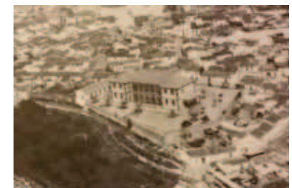
Fig.4: Se termina su construcción en el año 1933, fueron inauguradas por el Gobernador Civil de la provincia D. Manuel Banderas. Fuente: Winoco Marín Gallego.
