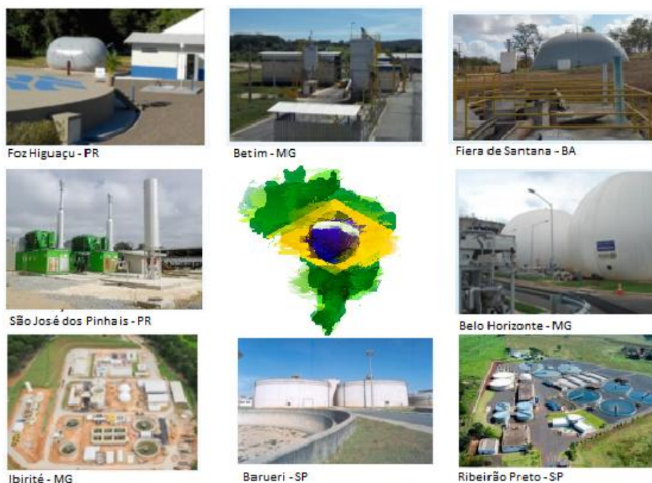
FIGURA 1 - ETEs com recuperação energética de biogás no Brasil (Fonte: autor).
