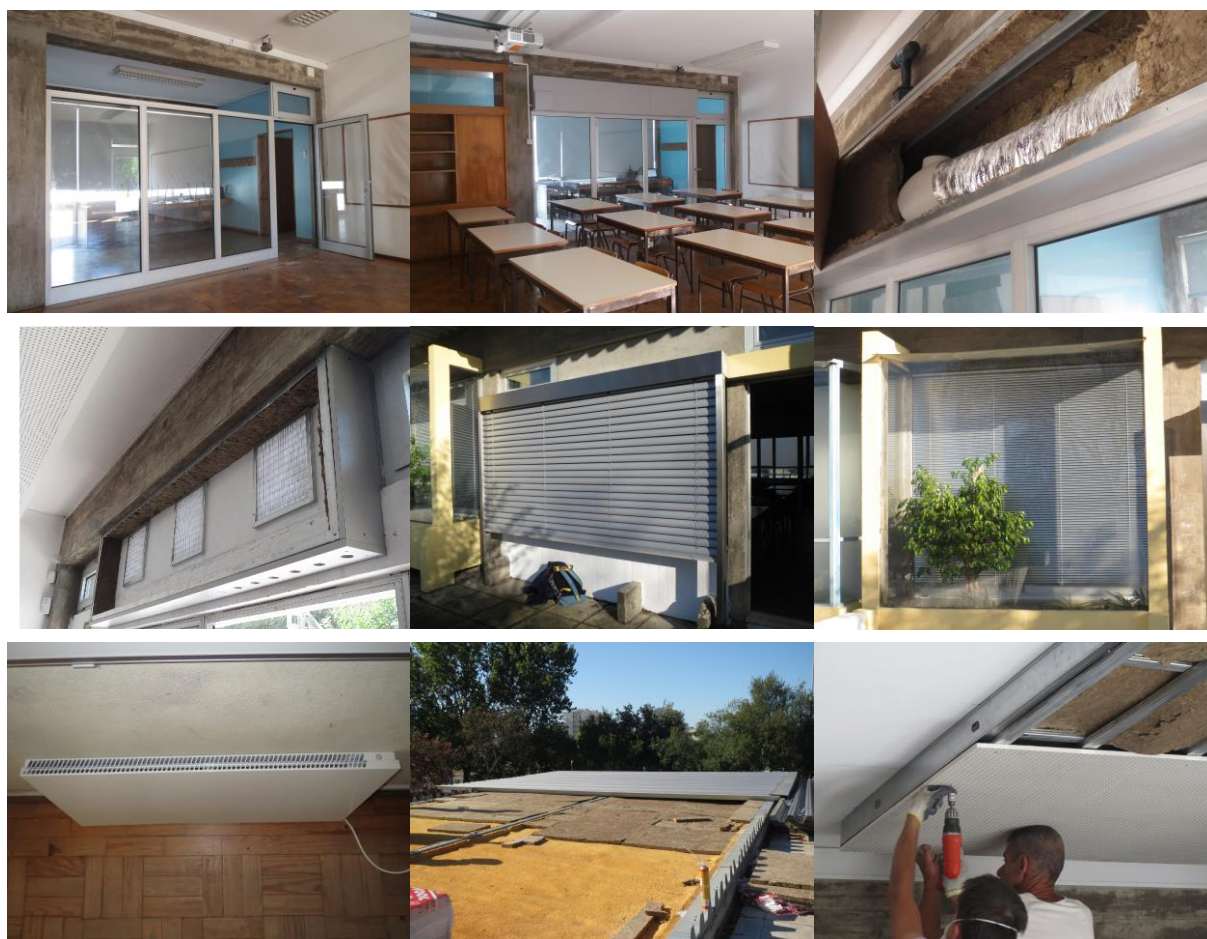
Figura 2. Intervenções na sala de aula protótipo.
