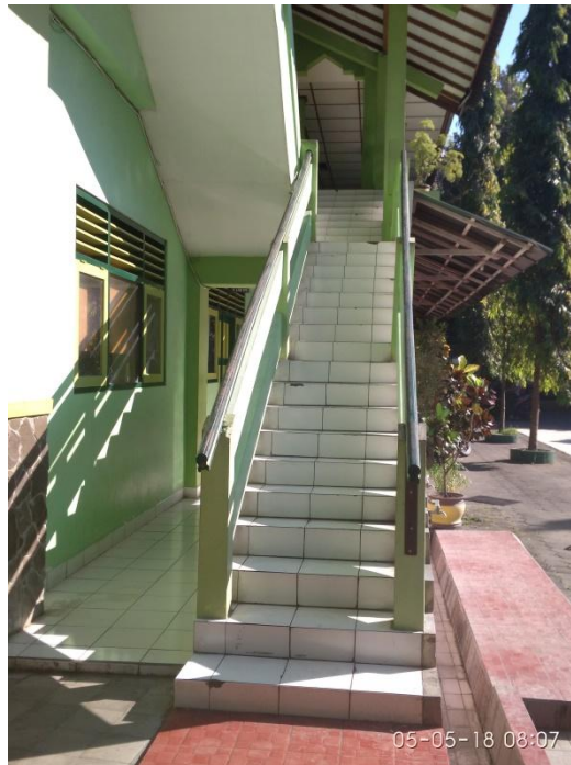
Gambar 3.5 Tangga menuju Ruang Komputer Sekolah KN
