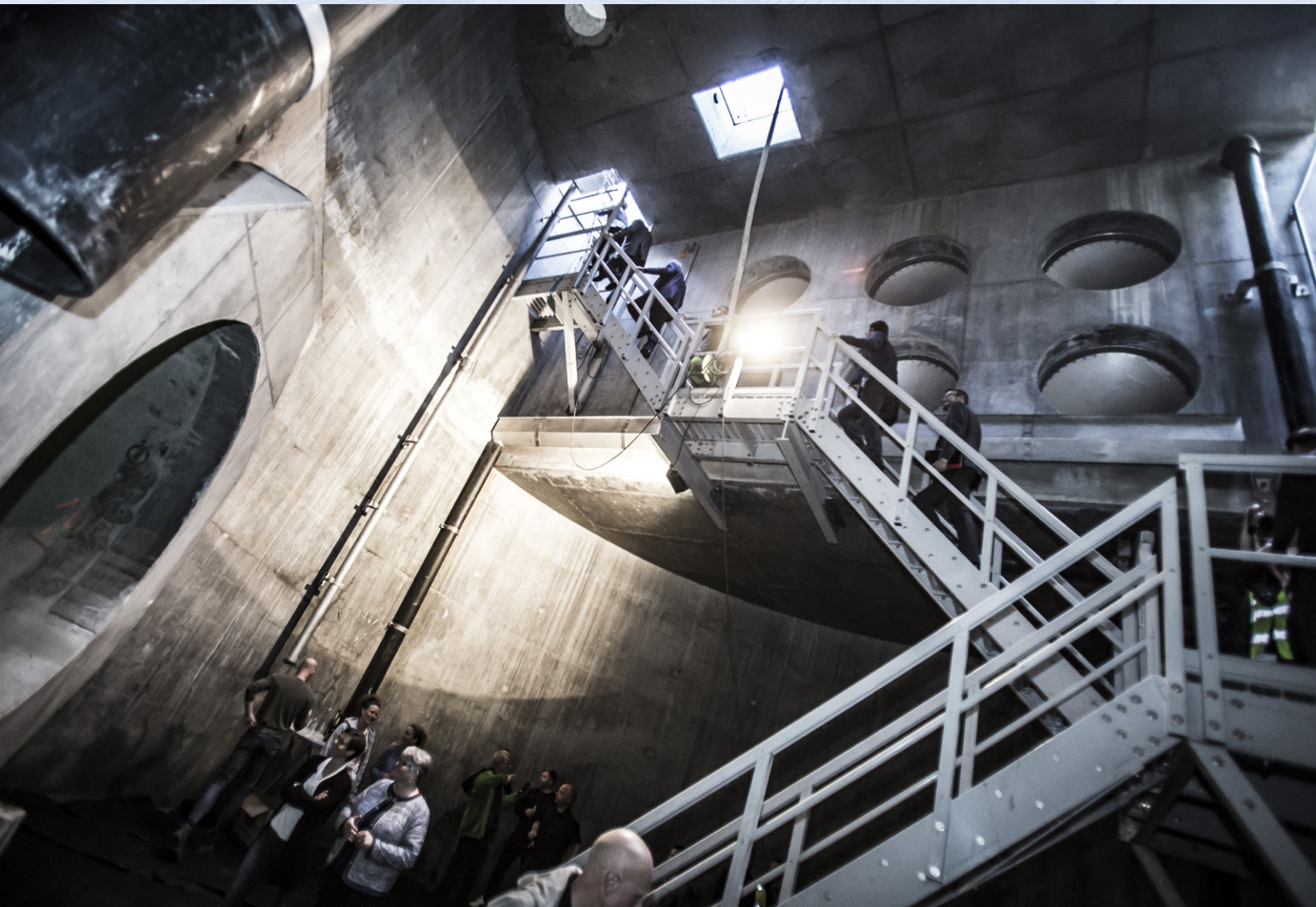
Østerbro tunnelen. Kilde: Ulrik M. Eriksen og HOFOR
