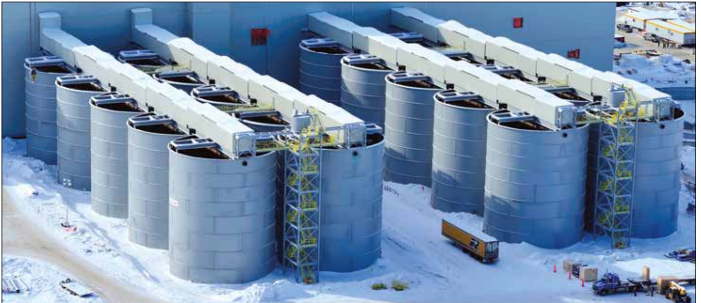
Figur 1. Fuldskala omrørte udludningsreaktorer i serie. Bemærk størrelsen af lastbilerne nederst til højre. Billedet stammer fra Fournier industries, Ontario, Canada.
