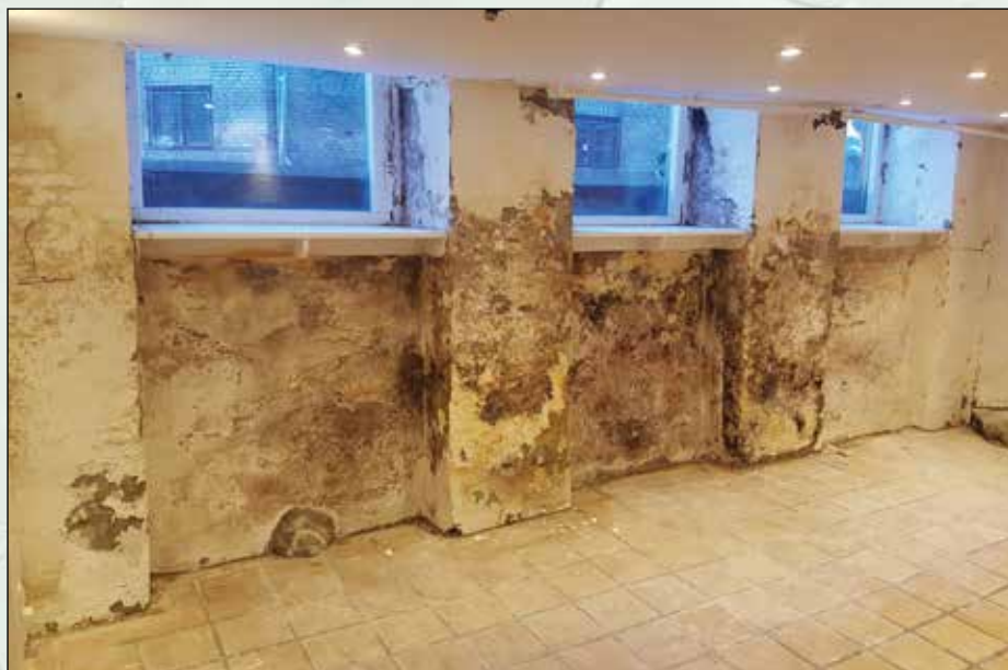
Før renoveringen af kælderrummet fandt sted.
